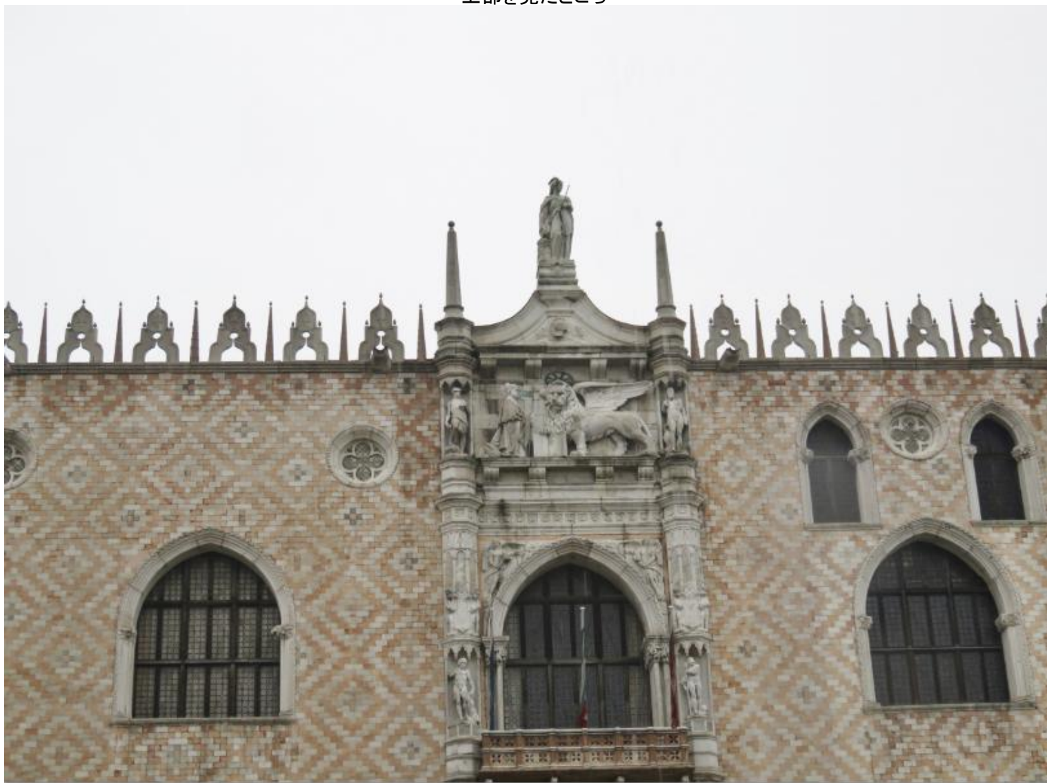
上部を見たところ
